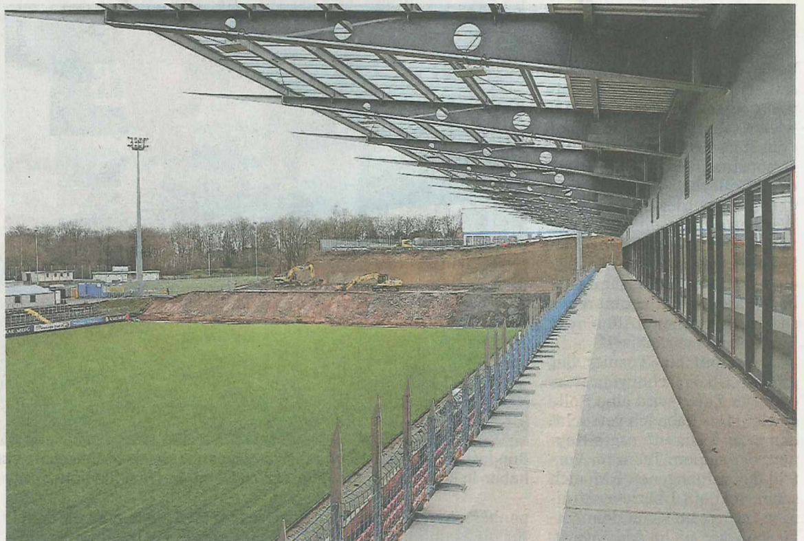
Im Elversberger Stadion geht's voran: Die Stehplatz-Tribüne für Heim-Fans ist abgerissen. Es entsteht ein doppelstöckiger Neubau. Auch der Ausbau der Haupttribüne macht Fortschritte. FOTO: SCHLICHTER
