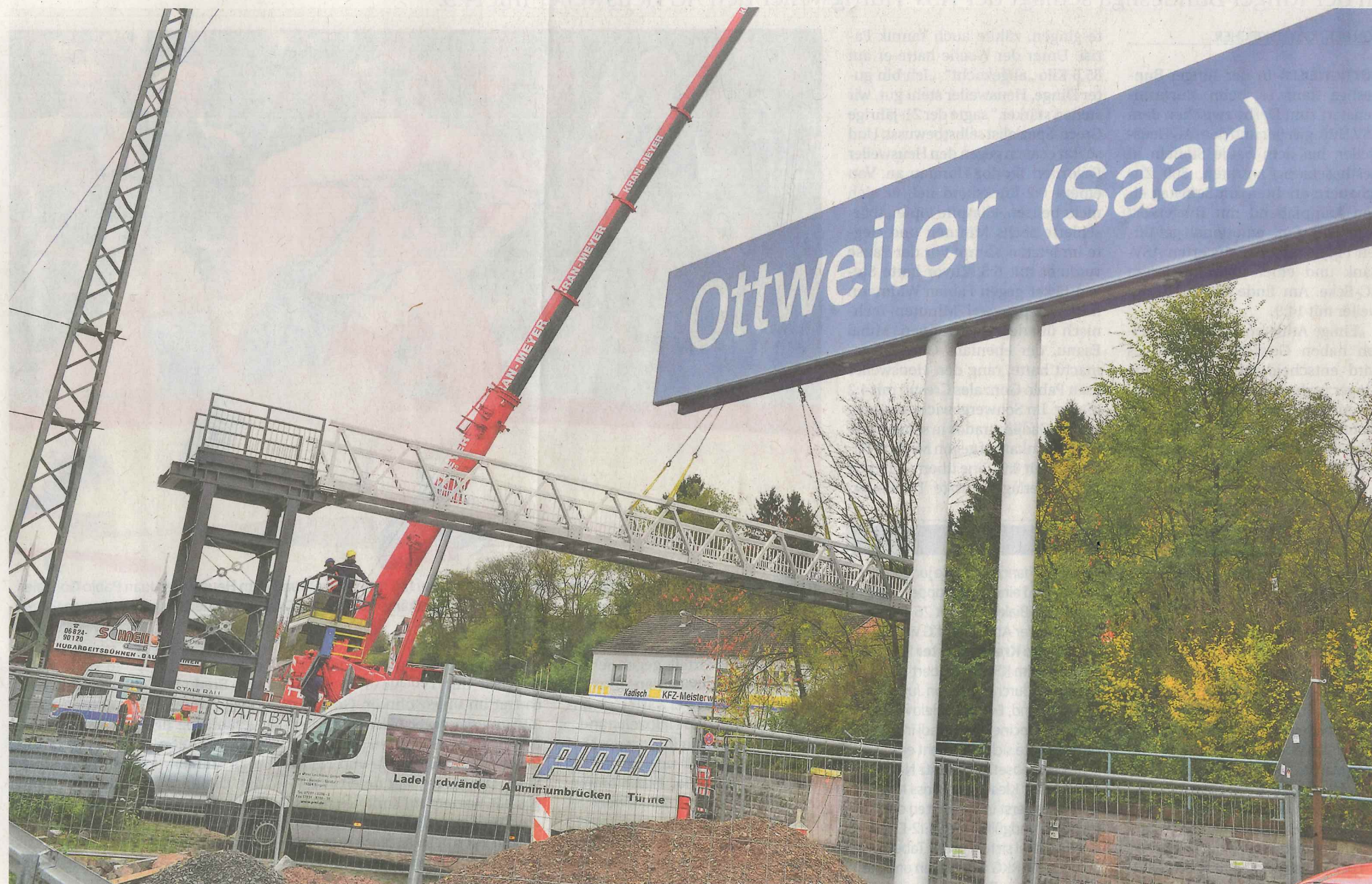
Die Bauarbeiten an der neuen Fußgängerbrücke über die Bahnlinie und über die Fürther Straße in Ottweiler gehen rasch voran. Jetzt wurde das erste Brückenteil verlegt.
