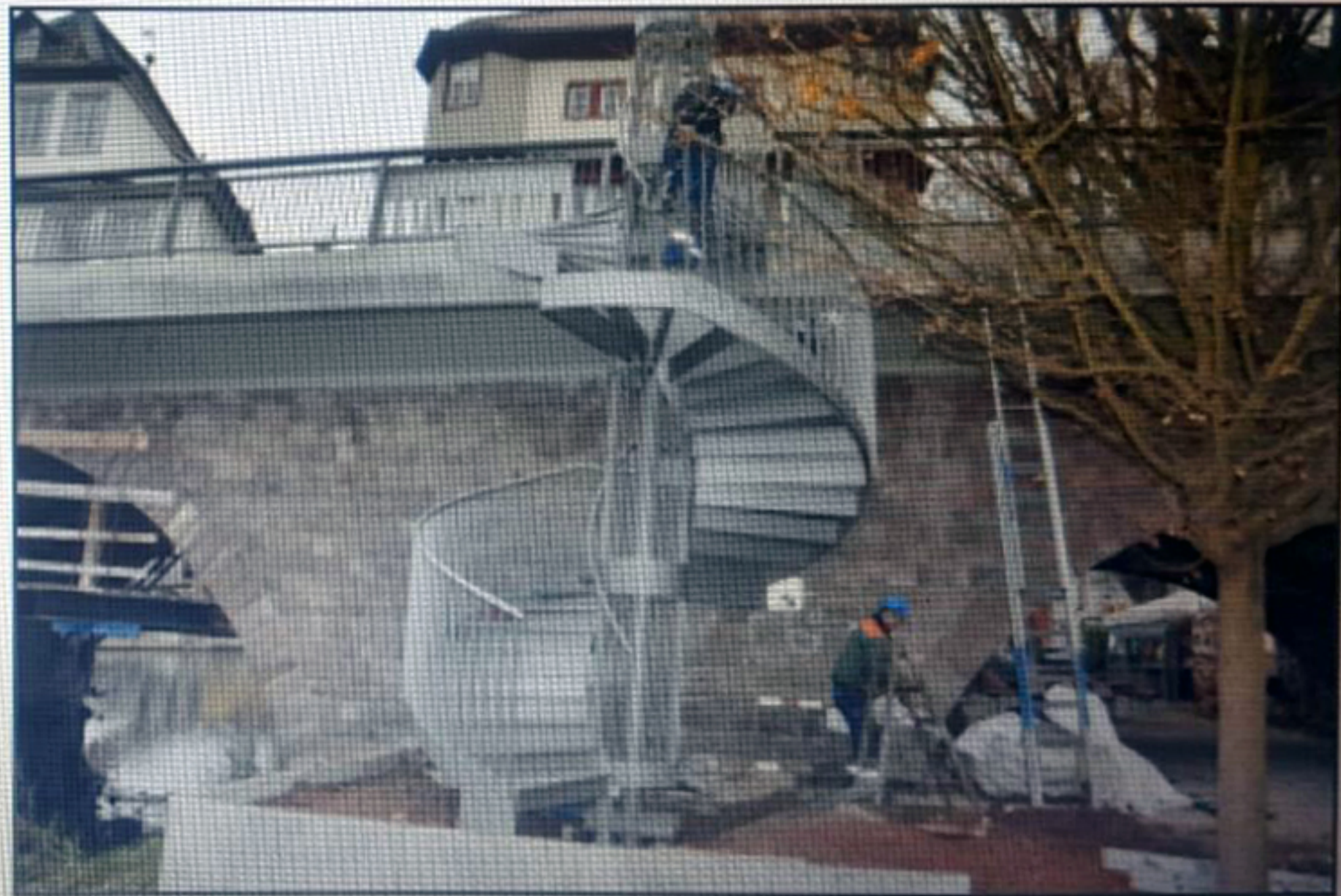
An Mühlenteichbrücke wurde eine Spindeltreppe aus Stahl montiert. Foto: Stadt Bad Kreuznach
